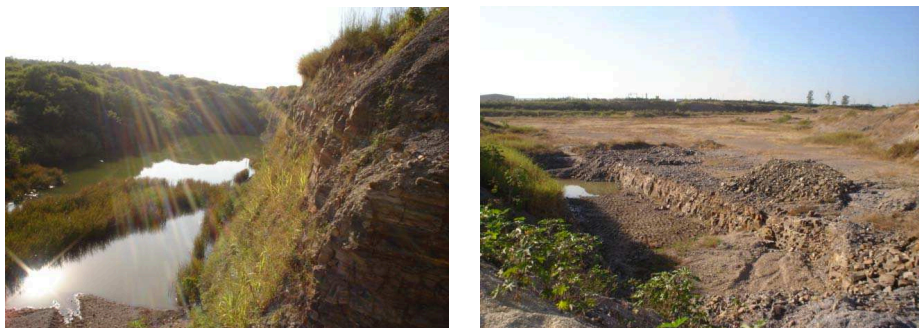
Figura 2. Cavas de mineração de calcário abandonadas, com grande potencial de ocorrência da drenagem ácida. Fotos: Marcio Roberto Soares e José Carlos Casagrande.
